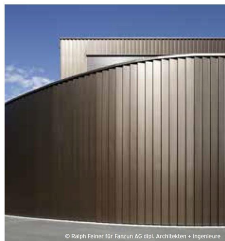
Pagrindinio fasado apdaila „V-MET“ arba analogiškas skardos lankstinys, spalva tamsiai pilka.
